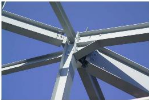
Balok Kolom (Profil I)
