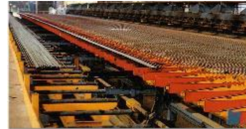
• Hot Rolling Mill
