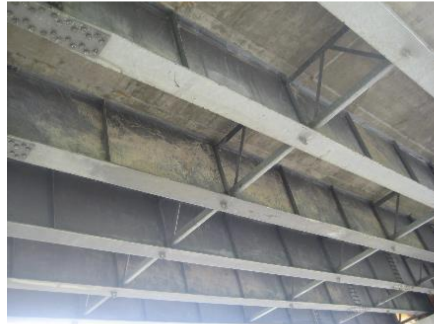
Struktur komposit dengan lantai beton
